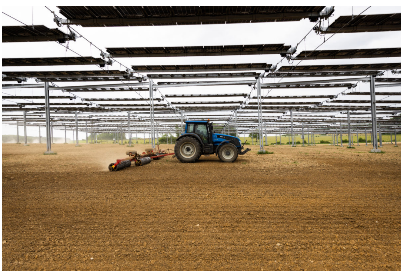
L'ombrière a une puissance de 2,4 MWc. Image : TSE
